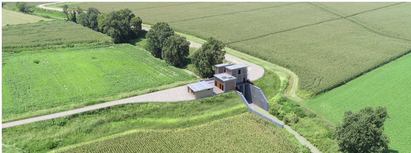
Figura 2: Struttura di regolazione – Stato di progetto: vista da monte con l'intervento di ringrosso e rialzo arginale
